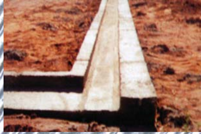
STEP 1 Pour a simple foundation
