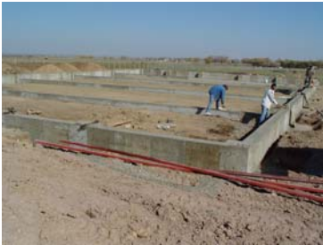
Pour concrete slab.
